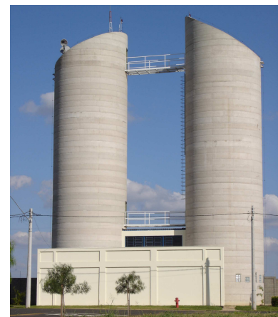
Vista depósito reservatório
