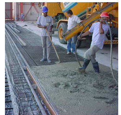
Concretagem do trilho.
