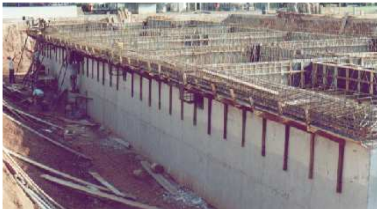
Vista panorâmica da estrutura de travamento.
