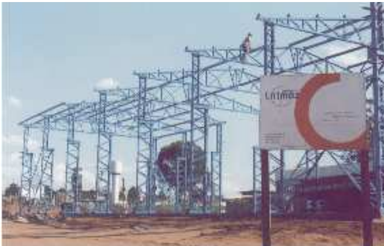
Montagem da estrutura metálica.
