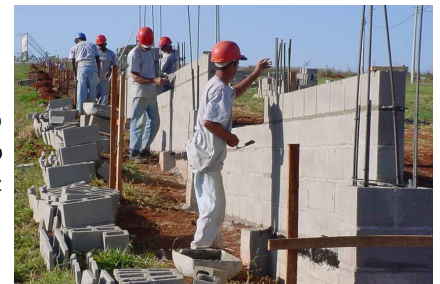
Execução da alvenaria.
