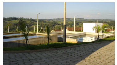
Vista do reservatório e ETA
