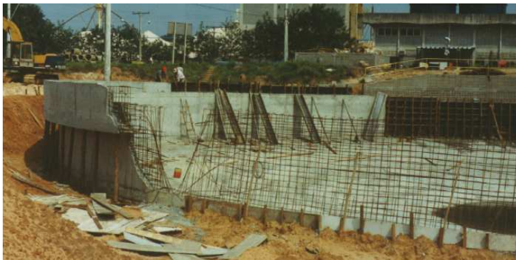
Concretagem das paredes do espessador
