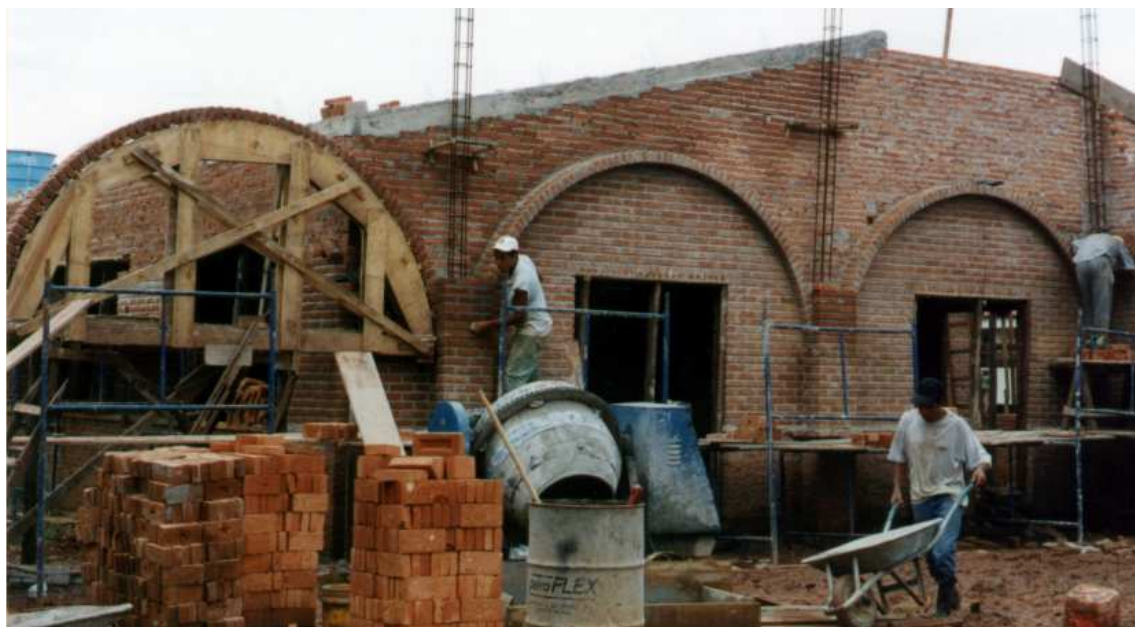
Execução dos arcos em alvenaria.
