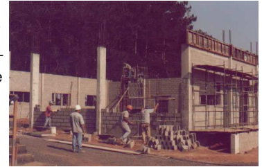
Superestrutura e alvenaria.
