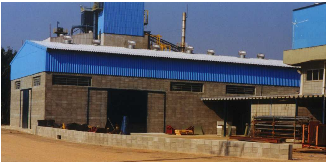
Galpão de manutenção pronto.
