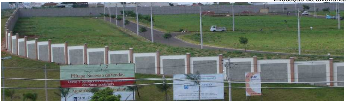
Vista geral do muro.
