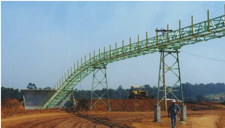
Muro de arrimo para moega e transportador de correia
