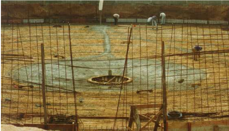
Ferragem laje fundo do espessador
