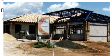
Construção centro de convívio
