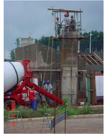
Concretagem da coluna.
