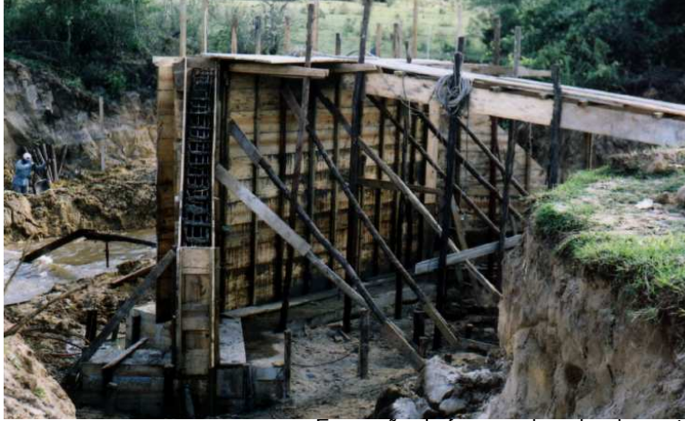
Execução de forma cabeceira da ponte.
