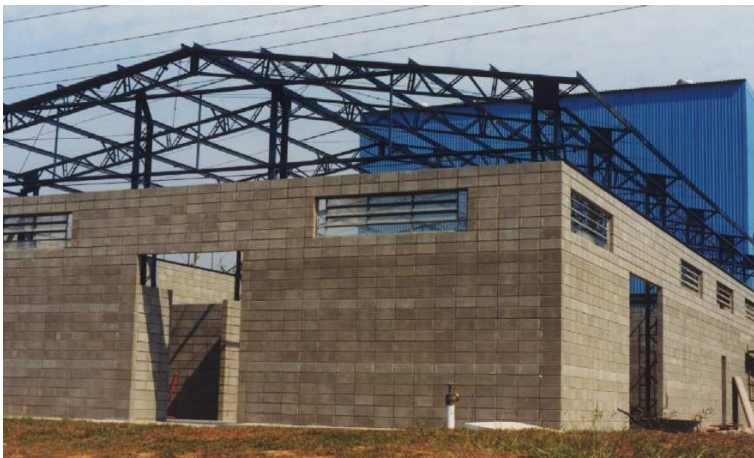
Galpão de manutenção em execução.
