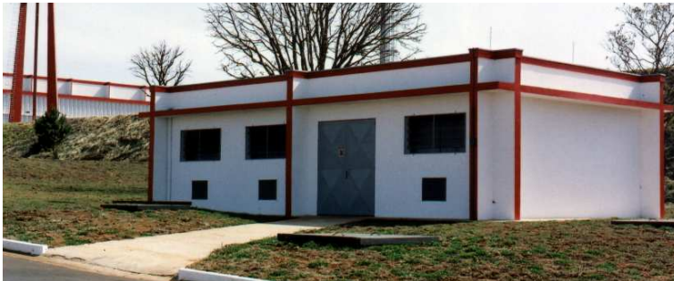
Vista externa da subestação SED-3.
