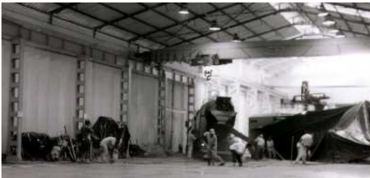
Lançamento do concreto na base injetora.
