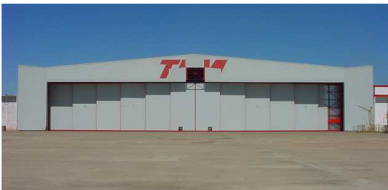
Vista frontal do hangar
