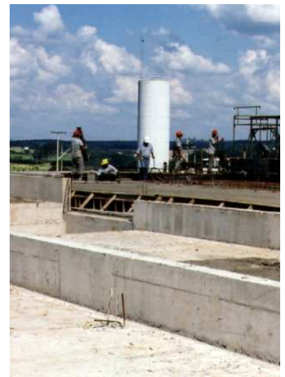
Concretagem de laje LAMIEL
