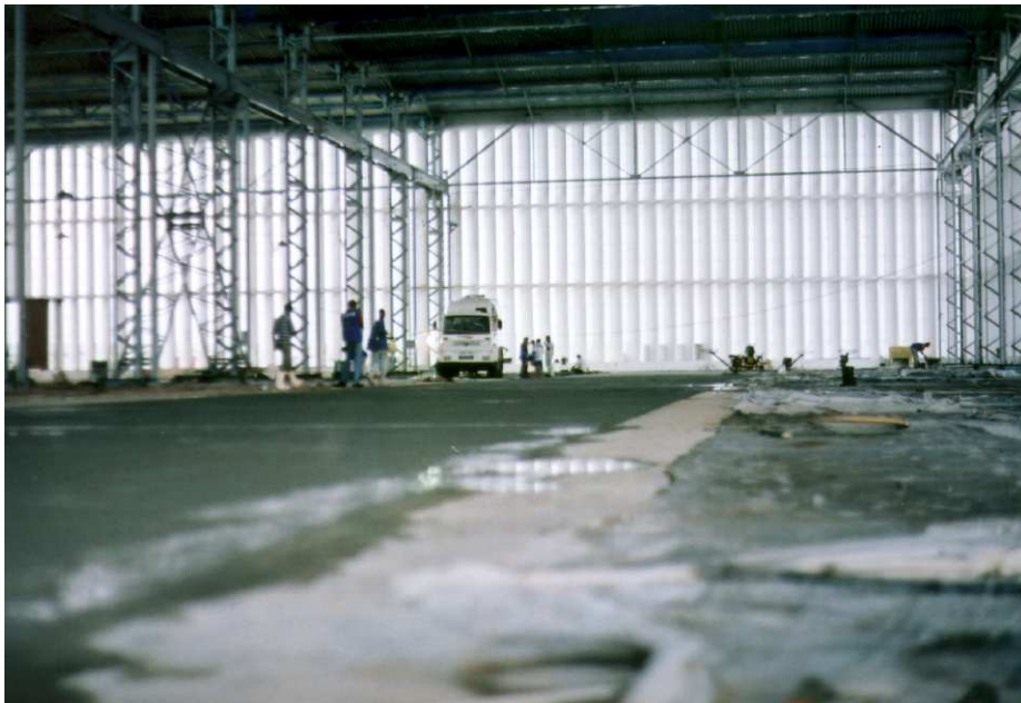
Lançamento do concreto piso de galvanoplastia.
