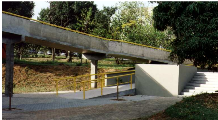
Rampa para deficientes físicos no AT4.
