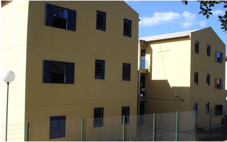
Vista externa do alojamento.
