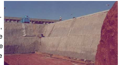
Escavação e estabilização talude..
