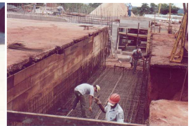
Preparo da ferragem.
