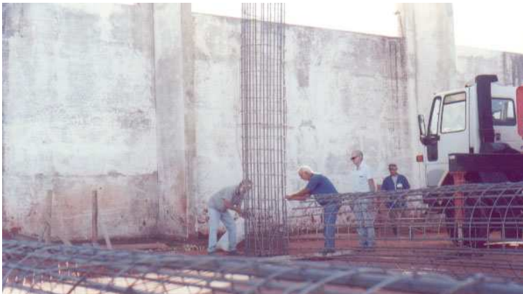
Ferragem tubulões
