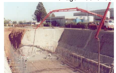
Concretagem do fundo.
