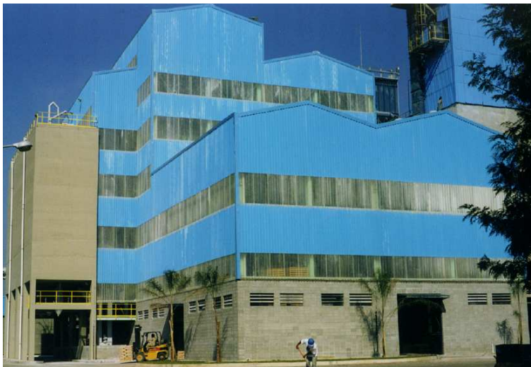
Vista externa do galpão moinhos
