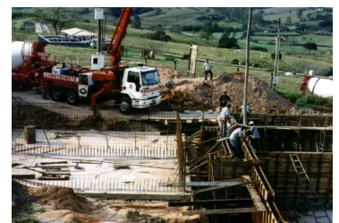
Concretagem das caixas da ETA
