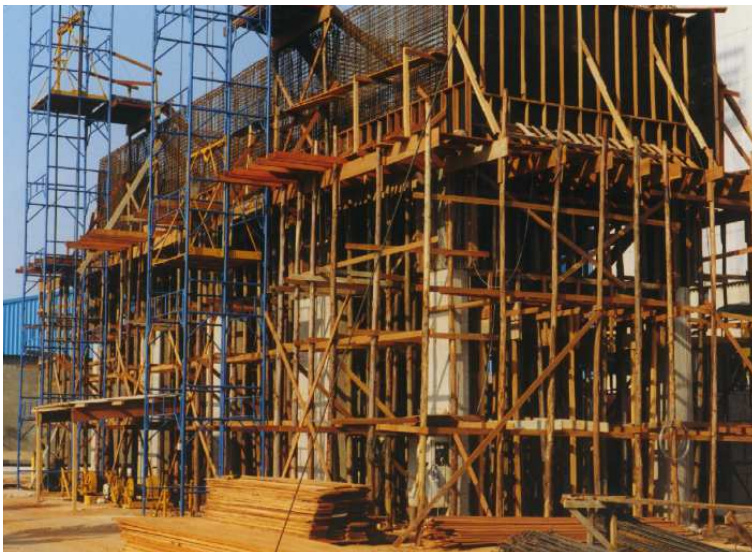
Superestrutura dos silos
