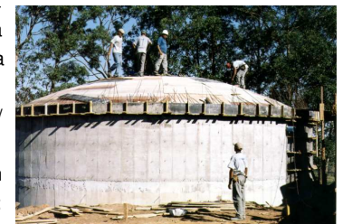
Execução de forma reservatório.
