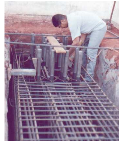
Montagem da armadura.
