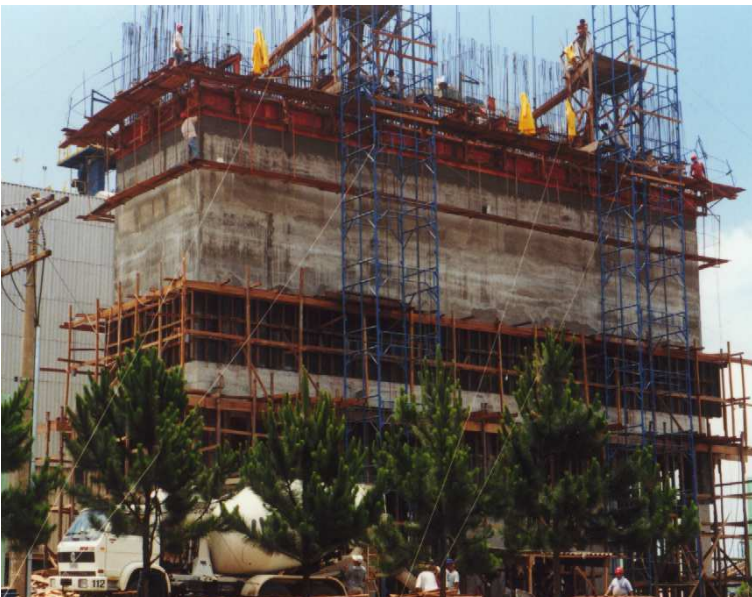
Forma deslizante paredes dos silos
