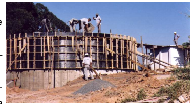
Concretagem do reservatório
