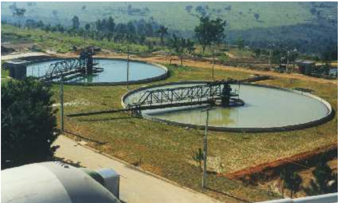
Vista dos Espessadores
