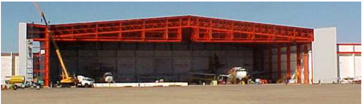
Vista frontal do hangar
