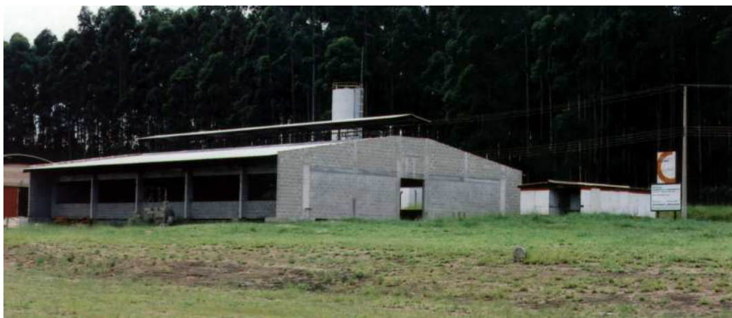
Vista externa do laboratório de Engenharia Civil .
